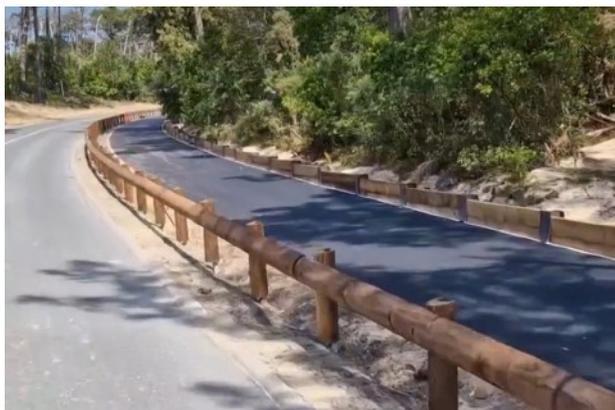
L'ouvrage impressionne par le travail très complet qu'il a nécessité : mise en place de palissades de confortement en certains points côté dune, et de passerelles en d'autres, surplombant les lettres. Une glissière de bois protège les cyclistes ; des passages ont été aménagés pour la faune sauvage, sur les conseils des chasseurs. Ces réalisations expliquent le coût élevé de cette opération : près de 2 M€.
