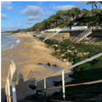
les vagues lors des tempêtes, et doivent être soigneusement vérifiés après chacune d'elles. Le recul de la pointe du Cap Ferret, qui apportait à nos plages une certaine protection, a multiplié les sinistres. On estime généralement que ces travaux d'entretien équivalent à une reconstruction totale tous les cinq ans ; le coût moyen d'une réfection est de 12 000 € par mètre linéaire.
